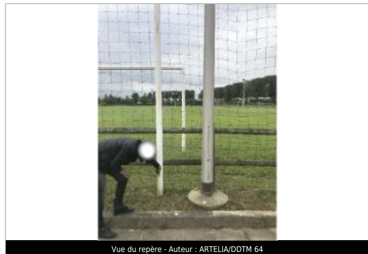
Vue du repère - Auteur : ARTELIA/DDTM 64
