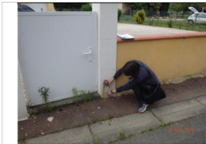
Vue du repère - Auteur : ARTELIA/DDTM 64
