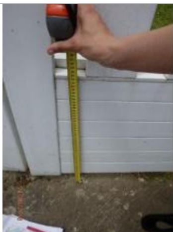
Vue du repère - Auteur : ARTELIA/DDTM 64
