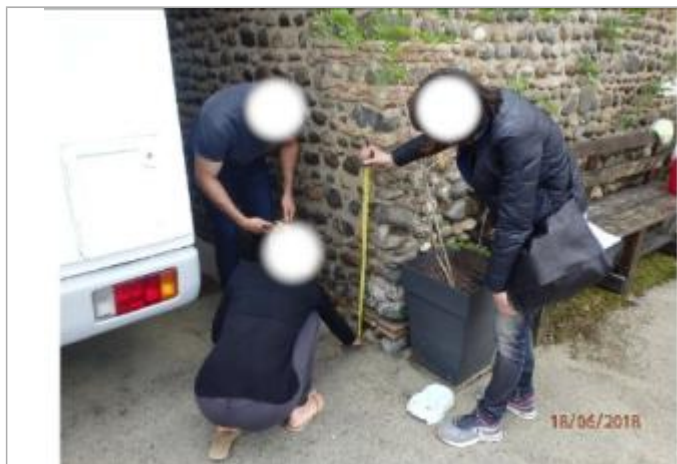
Vue du repère - Auteur : ARTELIA/DDTM 64
