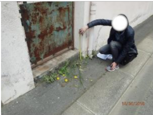
Vue du repère - Auteur : ARTELIA/DDTM 64
