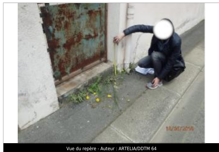
Vue du repère - Auteur : ARTELIA/DDTM 64
