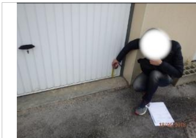
Vue du repère - Auteur : ARTELIA/DDTM 64
