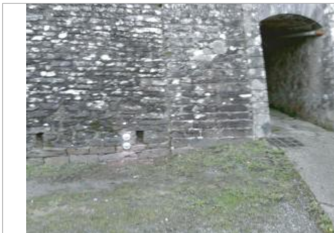
Ouvrage SNCF à proximité du moulin de Bouëxière
