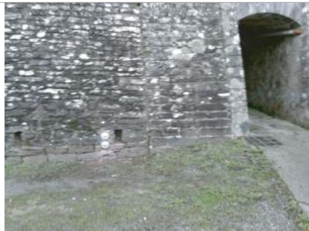
Ouvrage SNCF à proximité du moulin de Bouëxière
