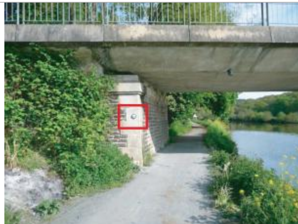
Pile du pont face aval
