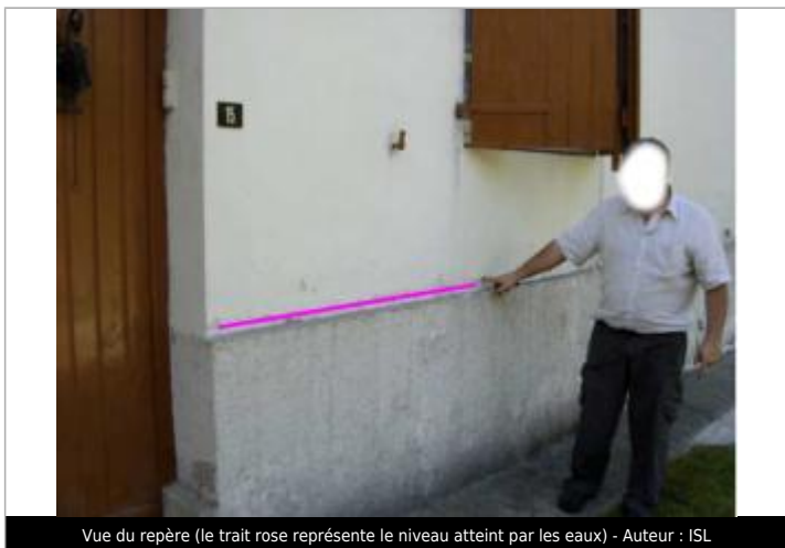
Vue du repère (le trait rose représente le niveau atteint par les eaux) - Auteur : ISL
