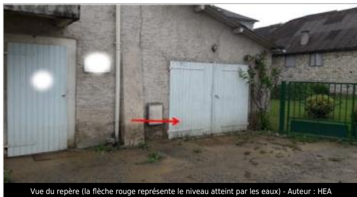
Vue du repère (la flèche rouge représente le niveau atteint par les eaux) - Auteur : HEA
