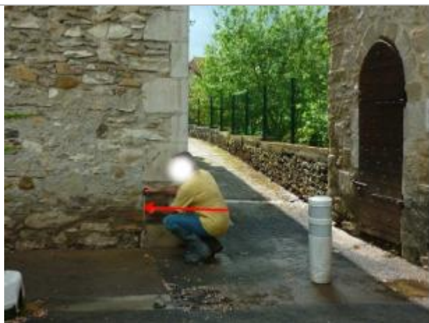
Vue du repère (la flèche rouge représente le niveau atteint par les eaux) - Auteur : HEA/DDTM 64
