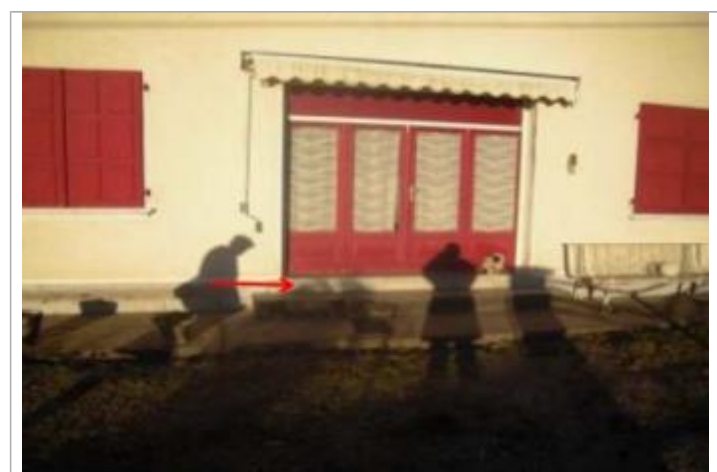
Vue du repère coté rue (la flèche rouge représente le niveau atteint par les eaux) - Auteur : HEA
