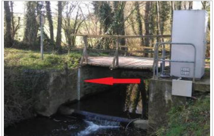
Station limnimétrique du Canut nord à Maxent
