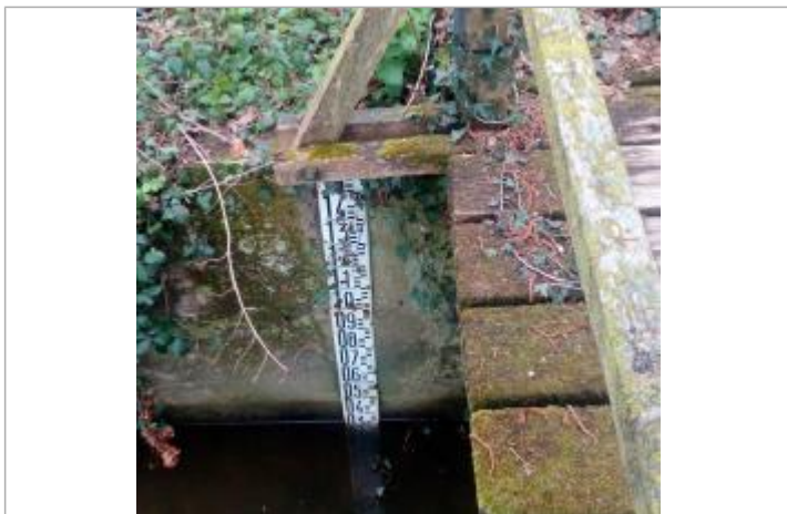
Echelle limnimétrique en aval du pont
