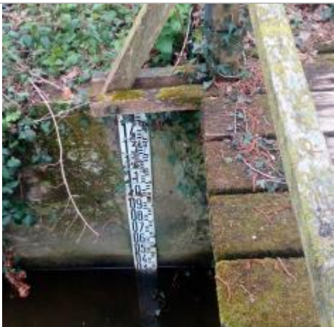
Echelle limnimétrique en aval du pont
