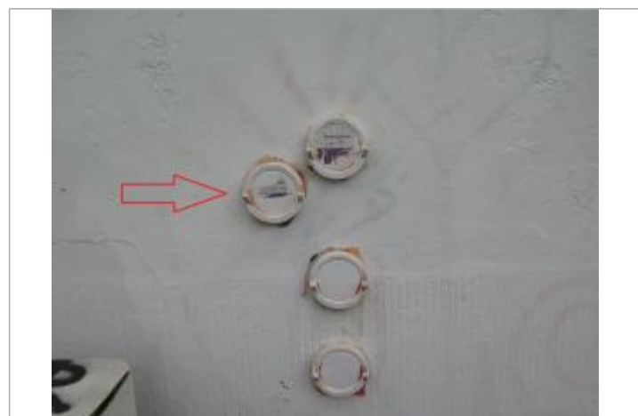
repère normalisé de la crue de Novembre 2000
