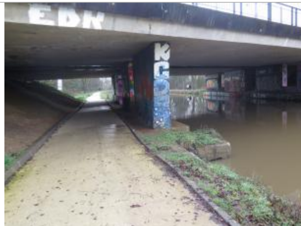
Pont du boulevard d'armorique, rive droite
