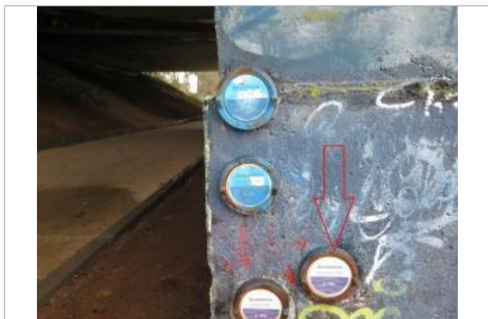
Pont du boulevard d'armorique, rive droite
