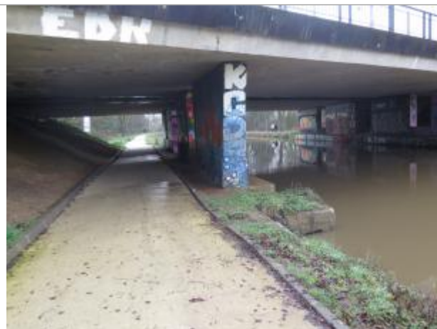
Pont du boulevard d'armorique, rive droite
