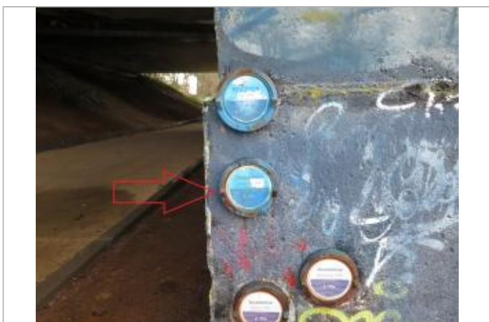
Pont du boulevard d'armorique, rive droite
