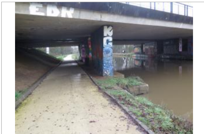
Pont du boulevard d'armorique, rive droite
