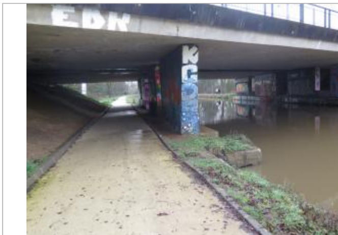
Pont du boulevard d'armorique, rive droite
