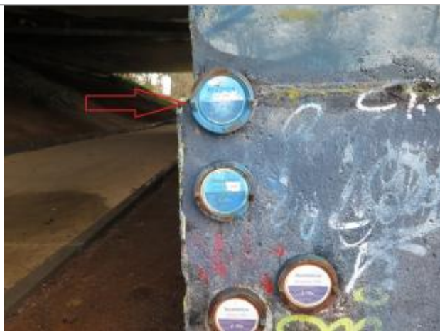
Pont du boulevard d'armorique, rive droite
