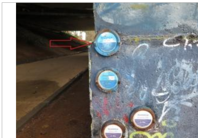
Pont du boulevard d'armorique, rive droite
