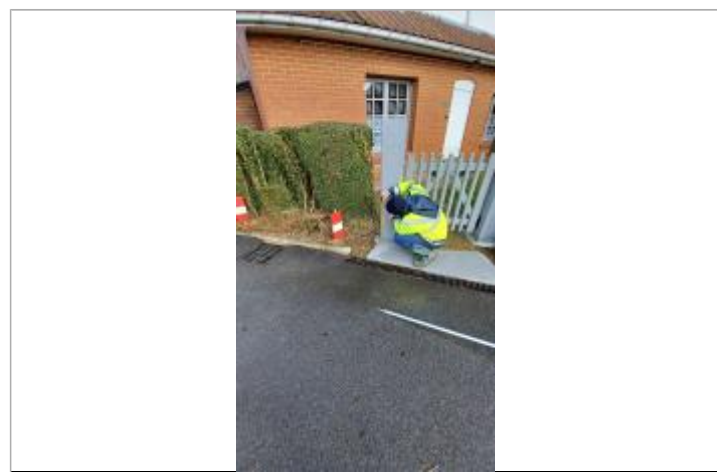
Dépôts de débris végétaux le long de la haie à 40 cm/sol.
