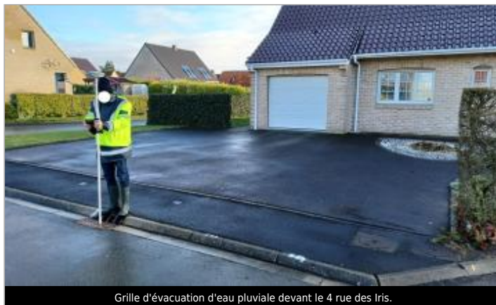
Grille d'évacuation d'eau pluviale devant le 4 rue des Iris.
