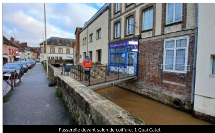
Passerelle devant salon de coiffure, 1 Quai Catel.
