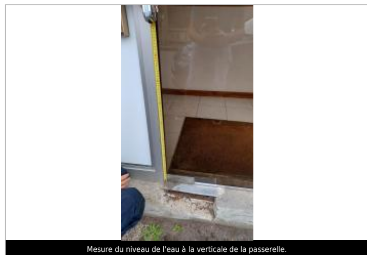
Mesure du niveau de l'eau à la verticale de la passerelle.
