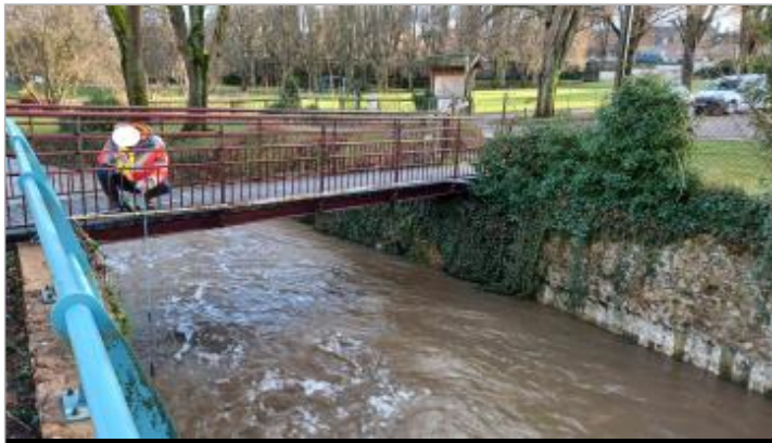
Mesure du niveau de l'eau à la verticale de la passerelle.
