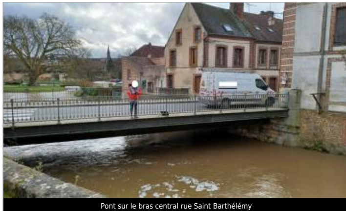
Pont sur le bras central rue Saint Barthélemy
