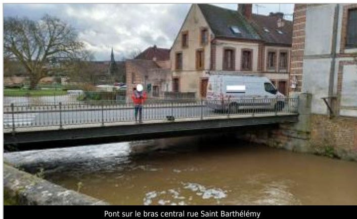
Pont sur le bras central rue Saint Barthélémy
