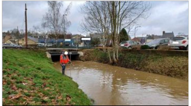
Berge rive gauche en amont du pont de l'avenue Kenedy sur le bras Gauche.
