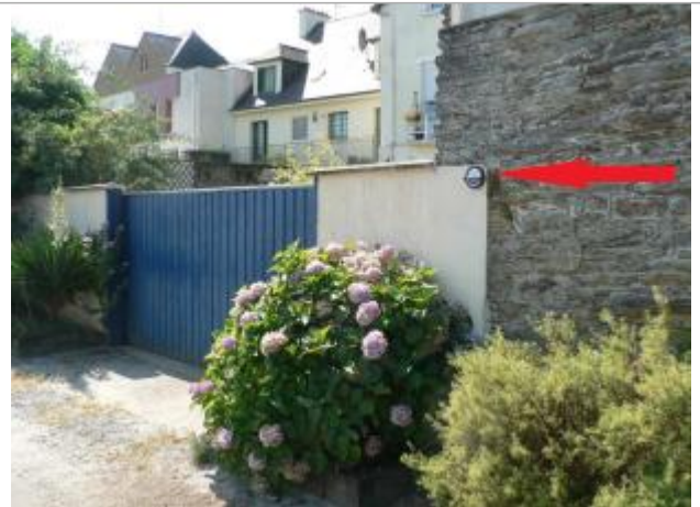
Mur de la propriété au 9 faubourg St-Julien coté chemin de halage
