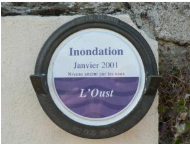
Repère normalisé de la crue de janvier 2001
