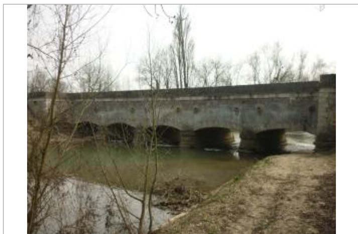
Pont-canal sur l'Armance (vue amont)
