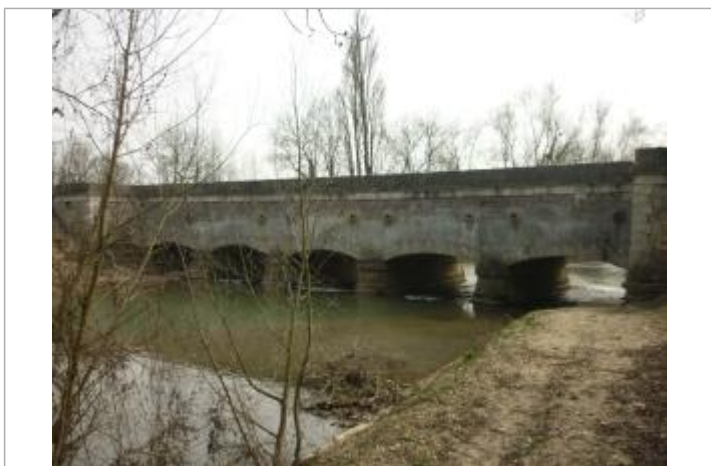
Pont-canal sur l'Armance (vue amont)
