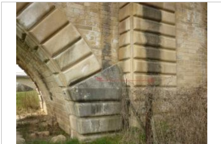
Culée amont du pont SNCF sur l'Armançon
