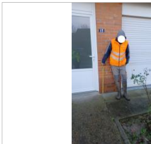
Laisse de crues sur mur de briques sur façade du pavillon à 46 cm/sol
