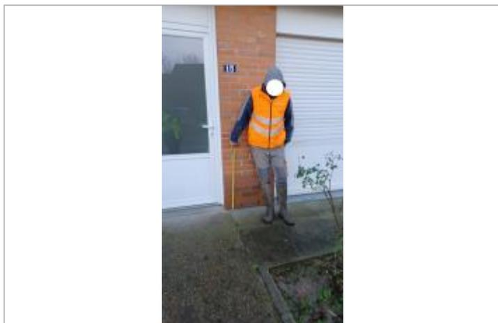
Laisse de crues sur mur de briques sur façade du pavillon à 46 cm/sol
