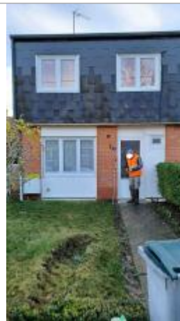
Mur en brique au 1 rue d'Arnèke
