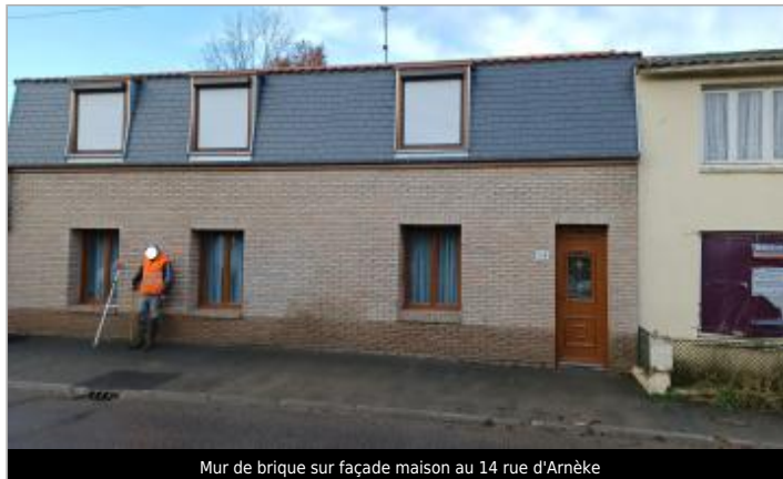
Mur de brique sur façade maison au 14 rue d'Arnèke
