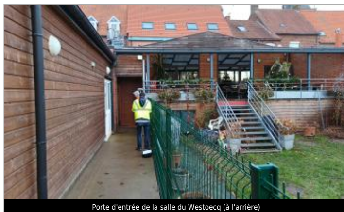
Porte d'entrée de la salle du Westoecq (à l'arrière)
