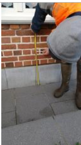
Laisse de crues sur mur de briques sur façade du pavillon à 52 cm/sol
