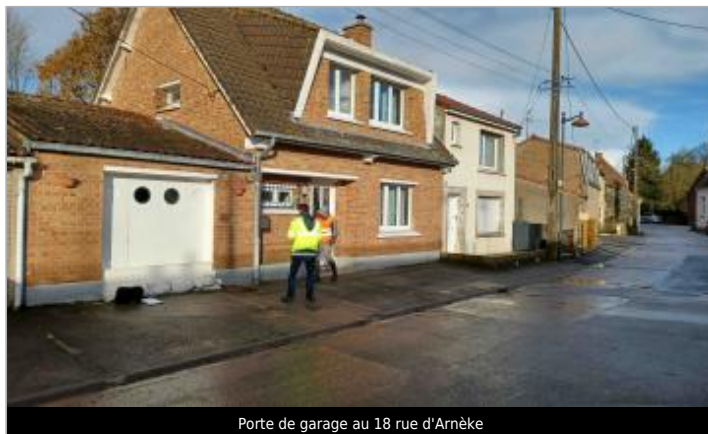
Porte de garage au 18 rue d'Arnèke
