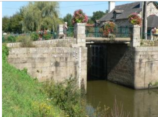
ecluse n°25 de Malestroit - échelle aval
