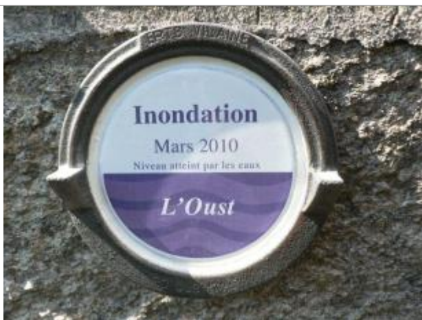
Repère normalisé de la crue de novembre 1930
