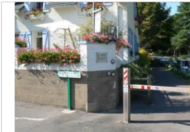
Mur de la propriété au 2 rue Madame à Malestroit
