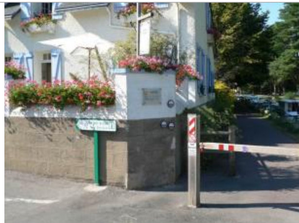
Mur de la propriété au 2 rue Madame à Malestroit
