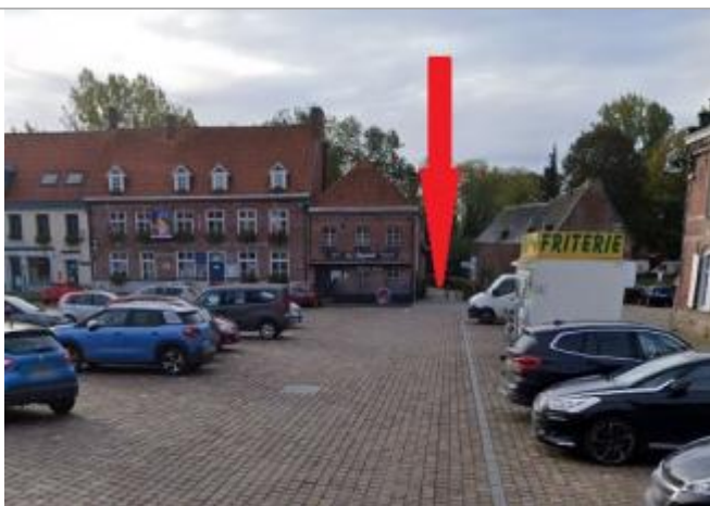
laisse de crue dans Allée traversière au niveau de la porte de service du restaurant
