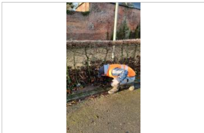
Laisse de débris de végétaux sur la haie en fer à 62 cm/sol.
