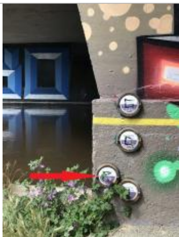
Repère normalisé de l'inondation du 29 décembre 1999
