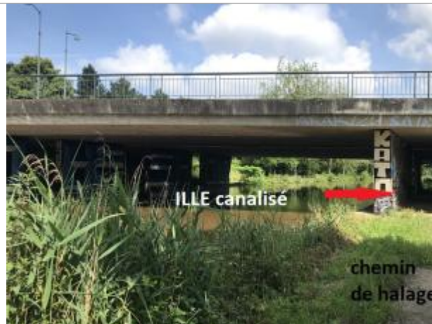
Pont d'Armorique rive gauche
