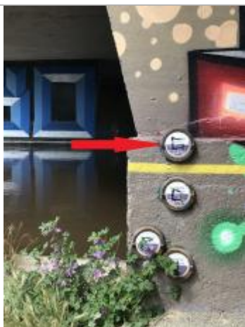
Repère normalisé de l'inondation du 14 mai 1981
