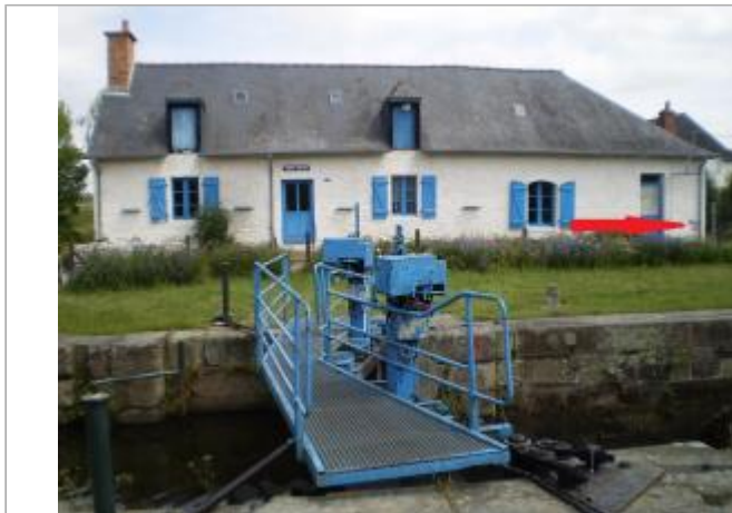
Maison éclusière de Pont-Réan à Bruz
