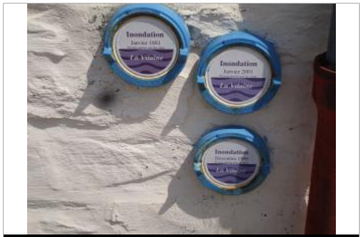
Repères de crues sur le mur de la maison éclésièrre
