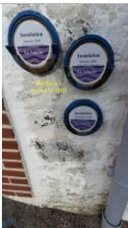
Différence entre la crue de 2025 et le repère de 2001 - photo Conseil Régional de Bretagne - voies navigables
