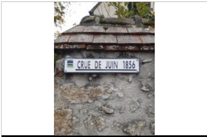
Vue rapprochée du repère, en 2021
