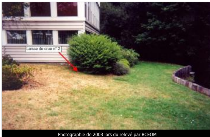
Photographie de 2003 lors du relevé par BCEOM
